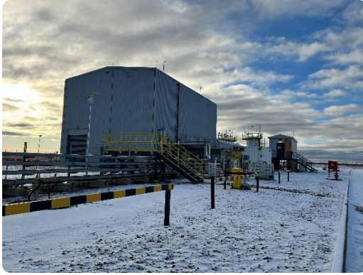
Proyecto Haru Oni de la firma HIF, en Magallanes. Aquí se produce hidrógeno a partir del agua mediante energía eólica, este se combina con dióxido de carbono para producir metanol y e-fuel. Este proyecto piloto, en el que también participan empresas japonesas y JOGMEC, es una iniciativa innovadora para el futuro.
