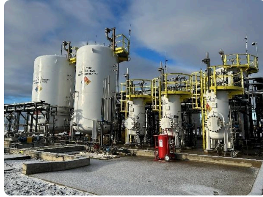
Proyecto Haru Oni de la firma HIF, en Magallanes. Aquí se produce hidrógeno a partir del agua mediante energía eólica, este se combina con dióxido de carbono para producir metanol y e-fuel. Este proyecto piloto, en el que también participan empresas japonesas y JOGMEC, es una iniciativa innovadora para el futuro.
