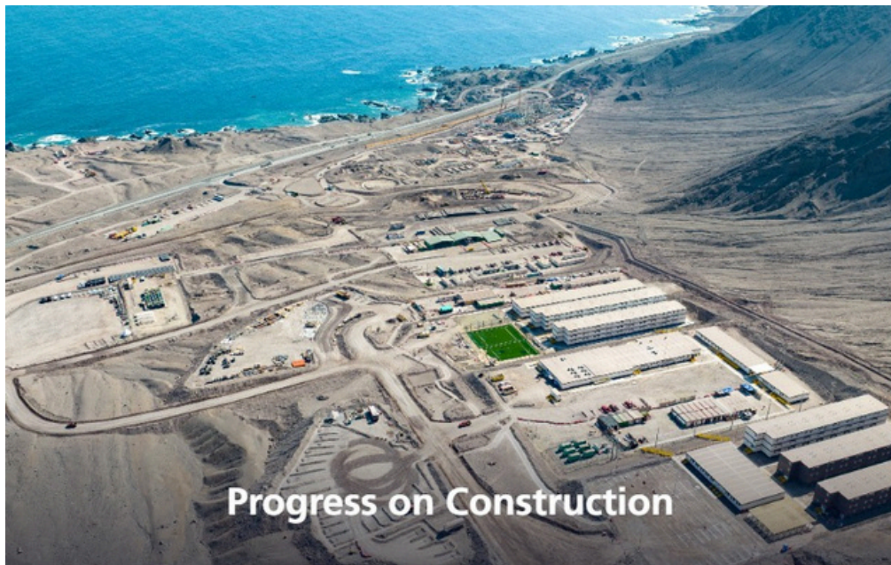
Fotografía del proyecto de desalinización de Marubeni Corporation para Codelco, en la Región de Antofagasta.
