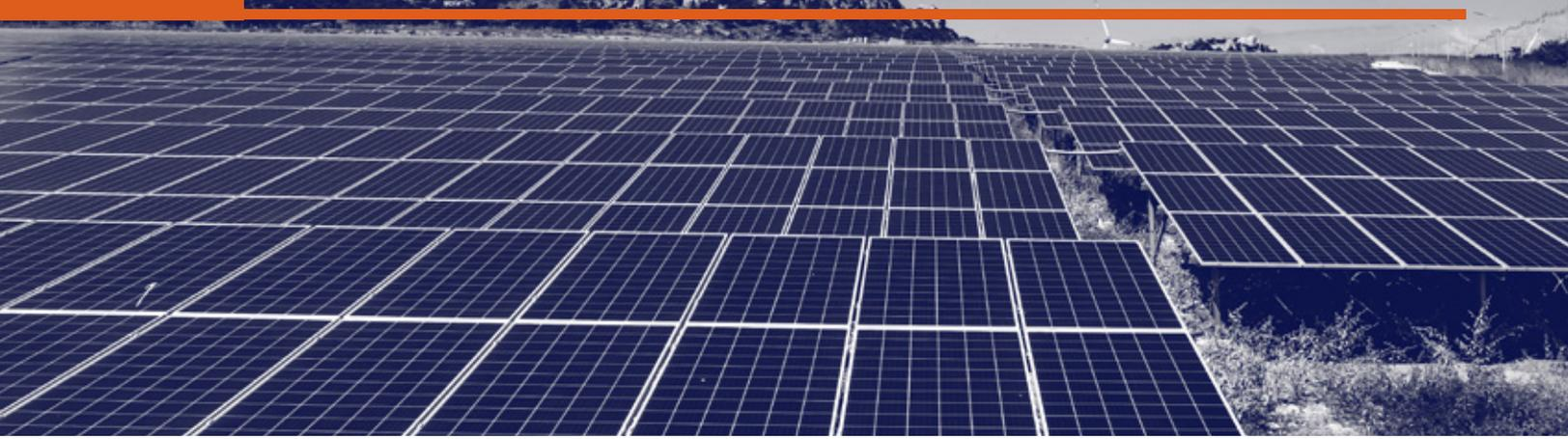
El fin del procesamiento de crudo tuvo como efecto liberar al 65% del terreno en Marsden Point para otros usos. Uno de estos es la generación de energía fotovoltaica. La empresa ya aprobó un parque solar de 26,7MW, cubriendo 37 hectáreas, con un costo total de NZ\$37 millones. Se espera que la planta compense emisiones de 18.000 toneladas de CO2 al año, a partir del 2023.<sup>126</sup>
